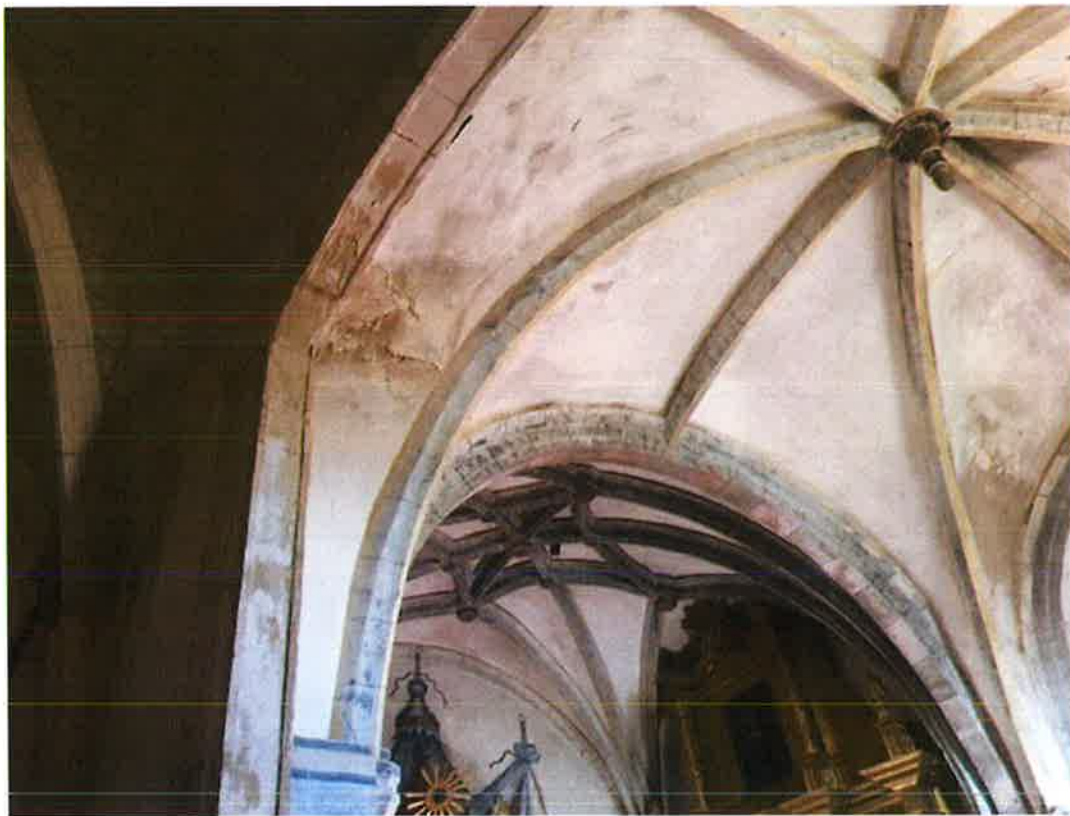
A su vez, se pueden apreciar diferentes zonas con humedades.
