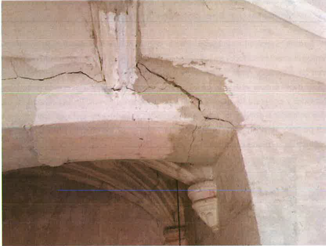
A su vez, se pueden apreciar diferentes zonas con humedades.
