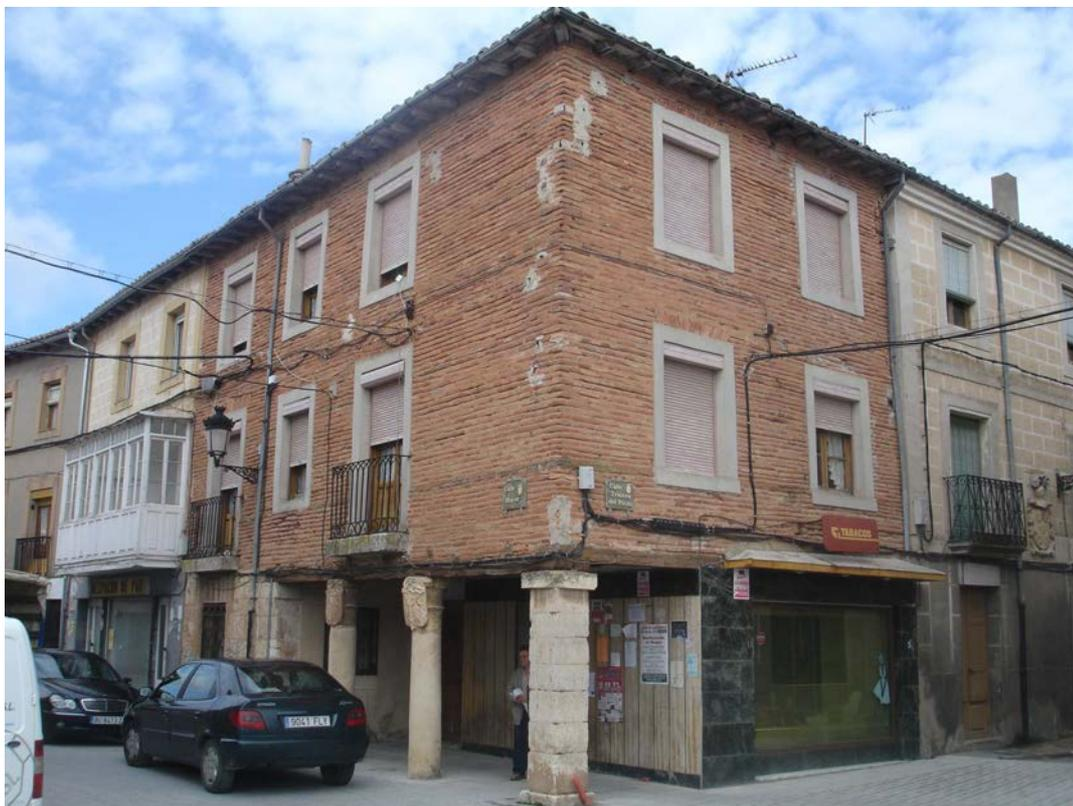
Casa tradicional, con soportal en planta baja y cuerpo superior de dos alturas. Pilares de piedra de interés, con escudos labrados en capitel. Pisos superiores de ladrillo macizo con llaga ancha. Alero formado con canes de madera de madera. Se han modificado los huecos originales, especialmente en planta baja, en que se ha eliminado casi por completo la fábrica de piedra.
