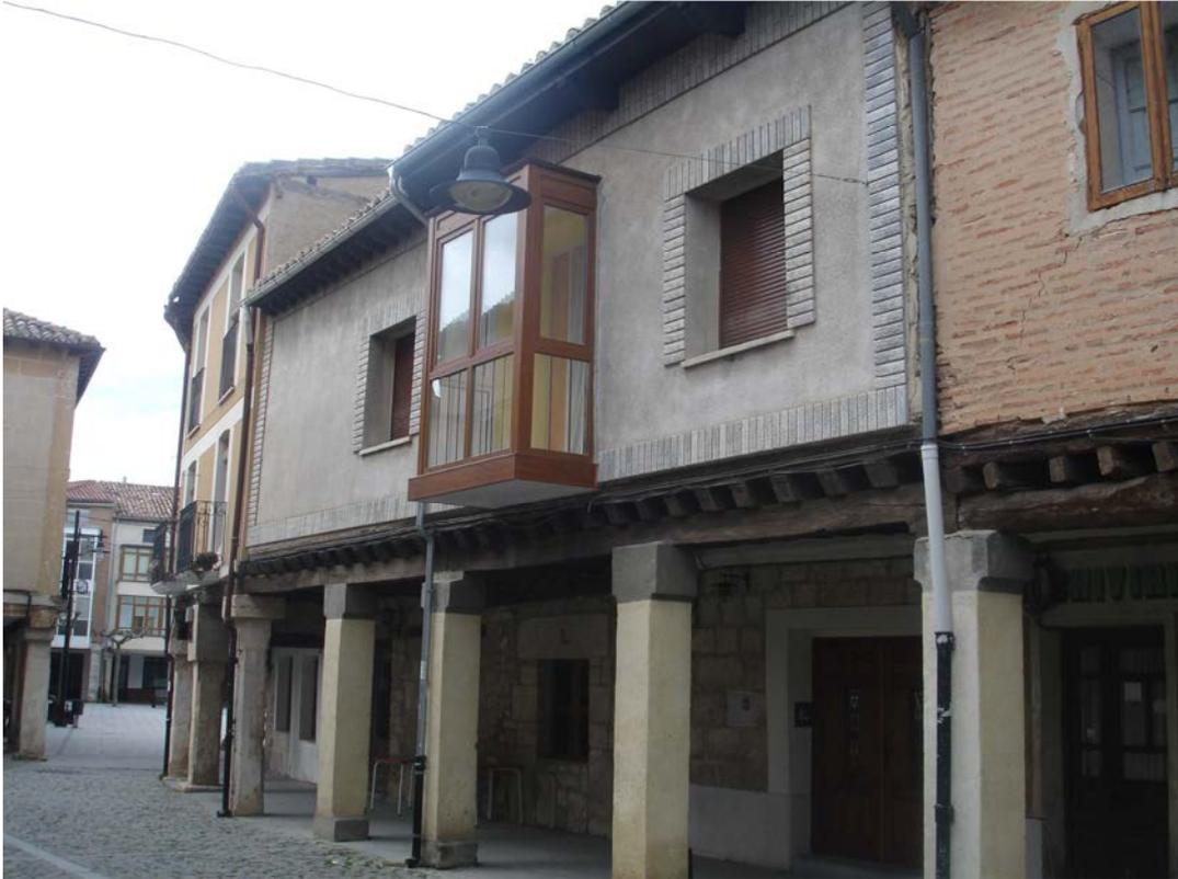
Construcción tradicional, situada en el eje más primitivo de la ciudad. Planta baja porticada. Se han sustituido los pies derechos por soportes de hormigón. Estructura de entramado de madera. Cuerpo superior enfoscado con plaqueta que enmarca igualmente los huecos. Alero de canes de madera. Galería en hueco central de planta primera.
