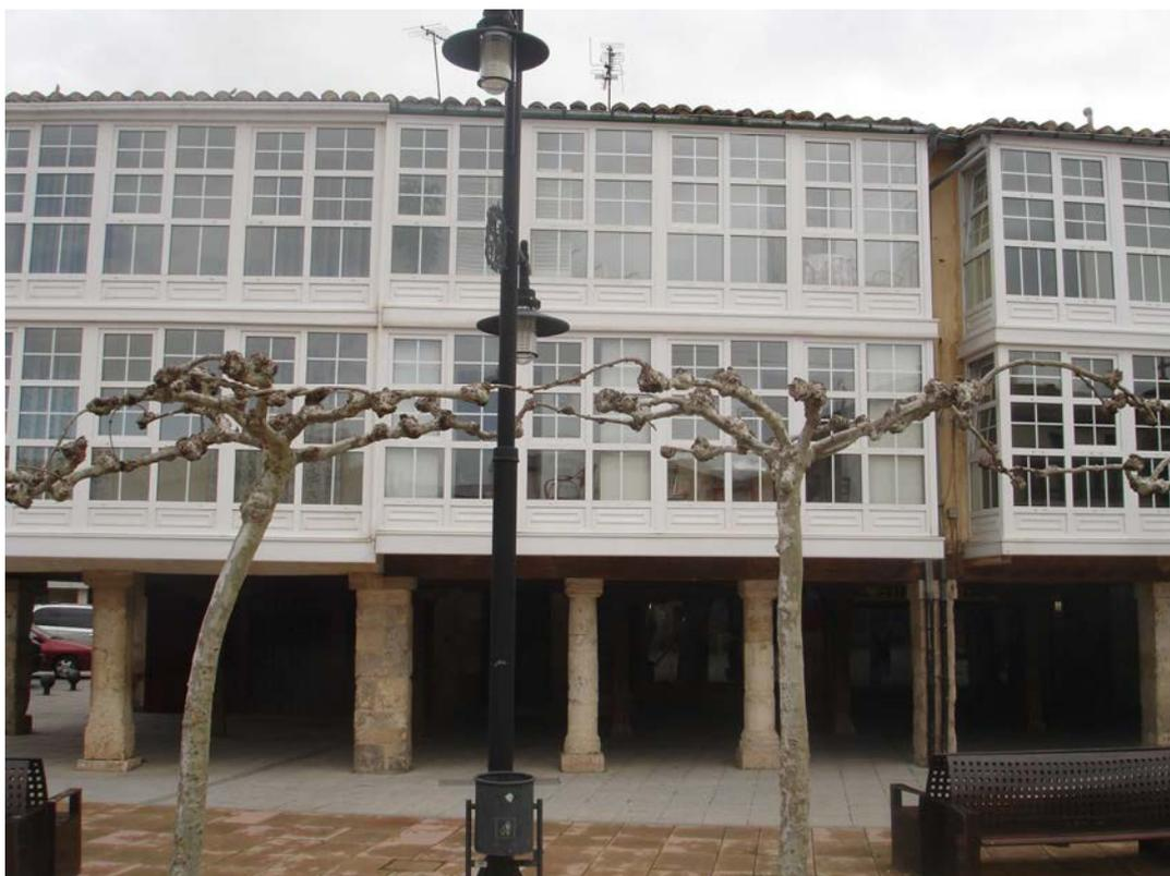
Edificio de viviendas levantado sobre el trazado de la antigua muralla. Destaca su soportal doble, que acredita su origen comercial y constituye el conjunto más característico del núcleo. Tres alturas, planta baja sobre pilares de piedra de sección cuadrada y estructura de madera. Galerías de acero en las dos plantas superiores
