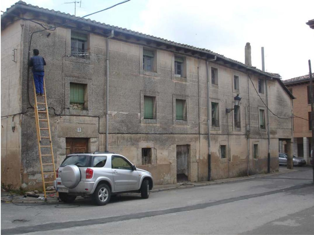
Edificio de vivienda. Tres plantas y tres ejes de vanos dispuestos con separación irregular. Fachada con revoco imitando sillería y enmarcado de huecos. Alero de canes de madera.
