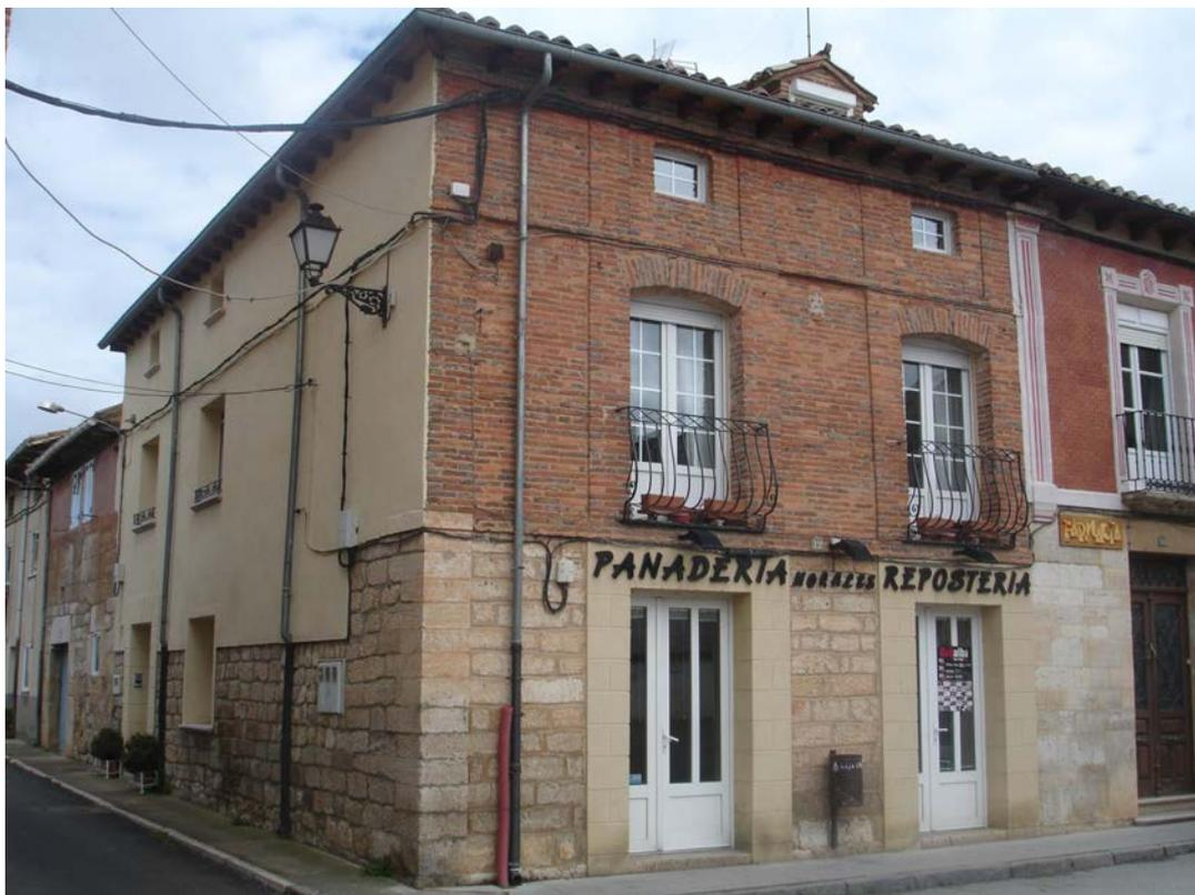
Edificio de vivienda en esquina . Dos plantas y desván, con dos ejes de vanos a fachada principal. Planta baja de mampostería. Cuerpo superior de ladrillo macizo, con disposición regular de huecos. Balcones en planta primera. Revoco en fachada lateral. Alero de canes de madera.
