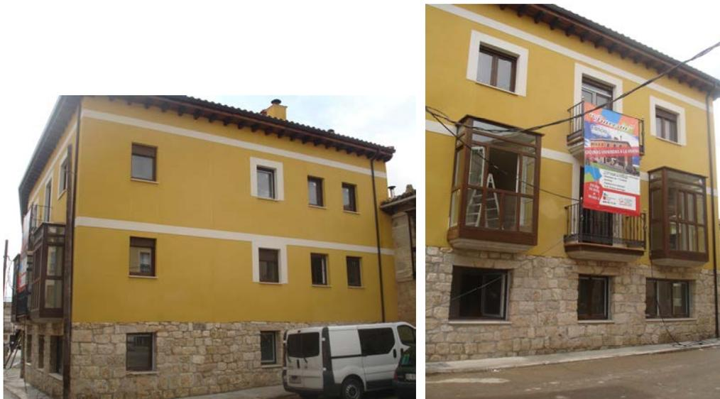
Edificio de vivienda en esquina. Tres plantas y tres ejes de vanos en fachada principal dispuestos de manera regular. Planta baja de mampostería y cuerpo superior de revoco con enmarcado de huecos e impostas. Galerías de madera en planta primera. Balcones en eje central. Alero de canes de madera.
