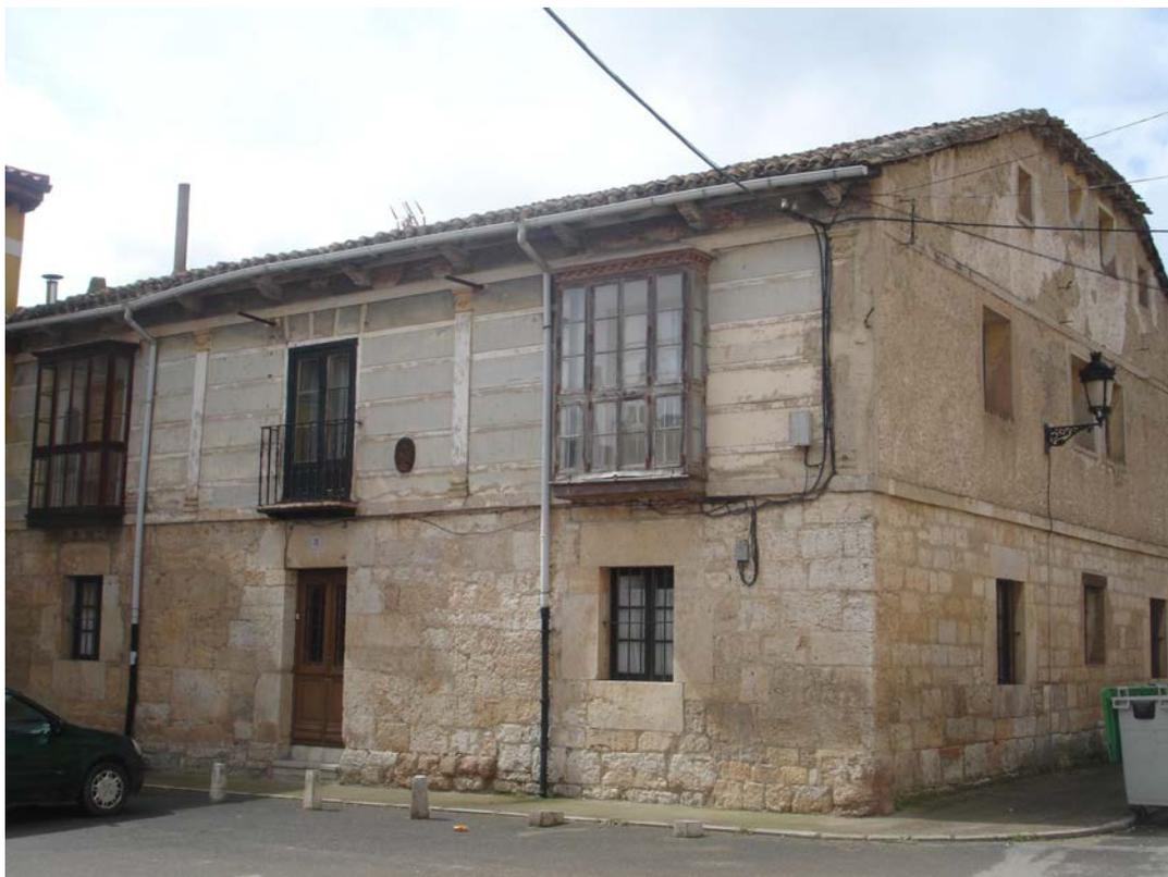
Caserón tradicional. Dos plantas y desván. Planta baja de mampostería, imposta de piedra y cuerpo superior con revoco. Galerías de madera en planta primera. Alero de canes de madera.
