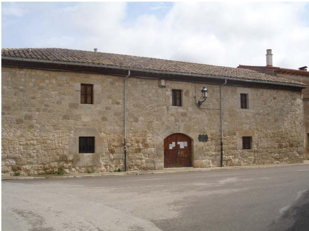
Se trata de una construcción tradicional del S. XVIII, de planta rectangular y patio, de dos alturas , construido en mampostería. La fachada se compone con tres ejes de huecos. Puerta de acceso central, con arco rebajado. Ha sido restaurado recientemente. En la fachada posterior se ha sustituido la piedra por un revoco y se han alterado algunos huecos. Cornisa con canes de madera.
