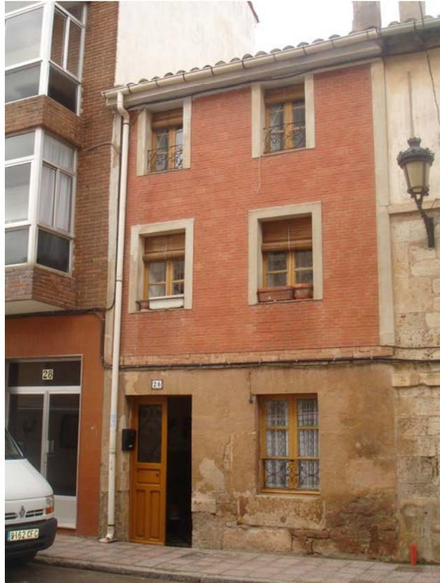
Edificio de vivienda. Tres plantas y dos ejes de vanos dispuestos en fachada. Planta baja de mampostería de piedra y cuerpo superior de ladrillo con enmarcado de huecos. Alero entablado y revestido.
