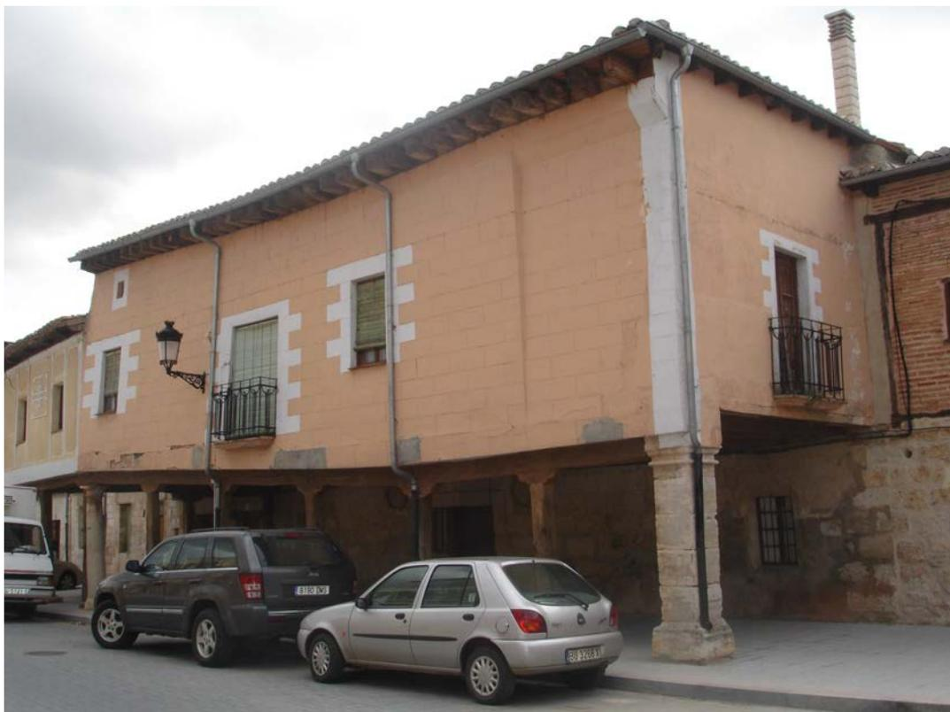
Edificio original del S. XVI, que en planta baja conserva aún vestigios de la época. Construcción tradicional, con soportal en planta baja de gran luz y dos plantas. Piedra en planta baja y entramado de madera en el resto. El piso superior ha sido visiblemente alterado en fechas posteriores. Portada de acceso con cerco retallado y flanqueada por dos escudos de armas.
