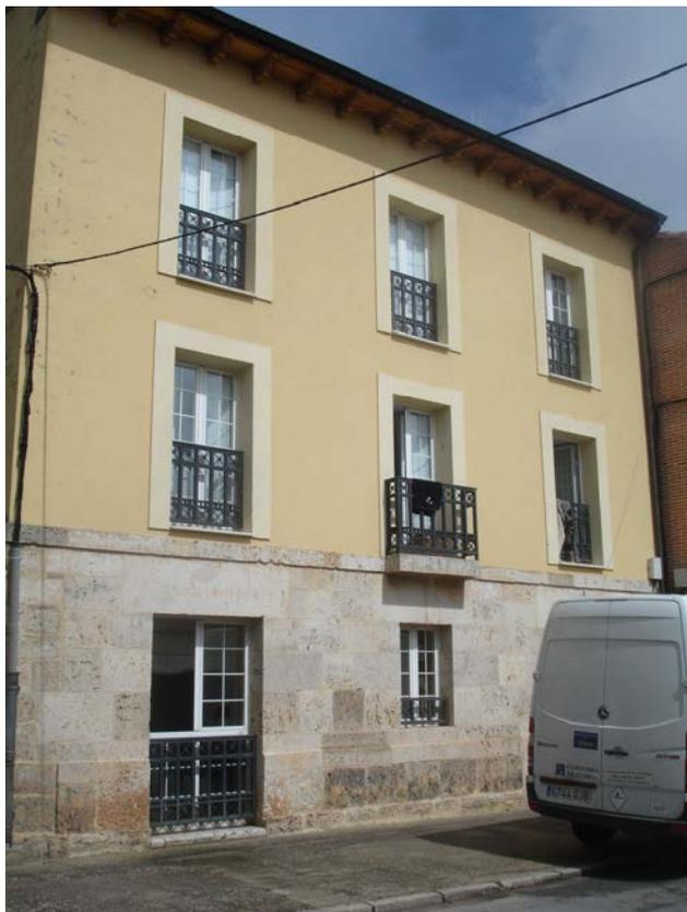
Edificio de vivienda. Tres plantas, tres ejes de vanos . Planta baja de sillería con dinteles de una pieza. Cuerpo superior con huecos regulares , de ladrillo macizo, con arcos de descarga de ladrillo. Revoco con fingido de sillares y enmarcado de huecos. Alero de canes de madera.
