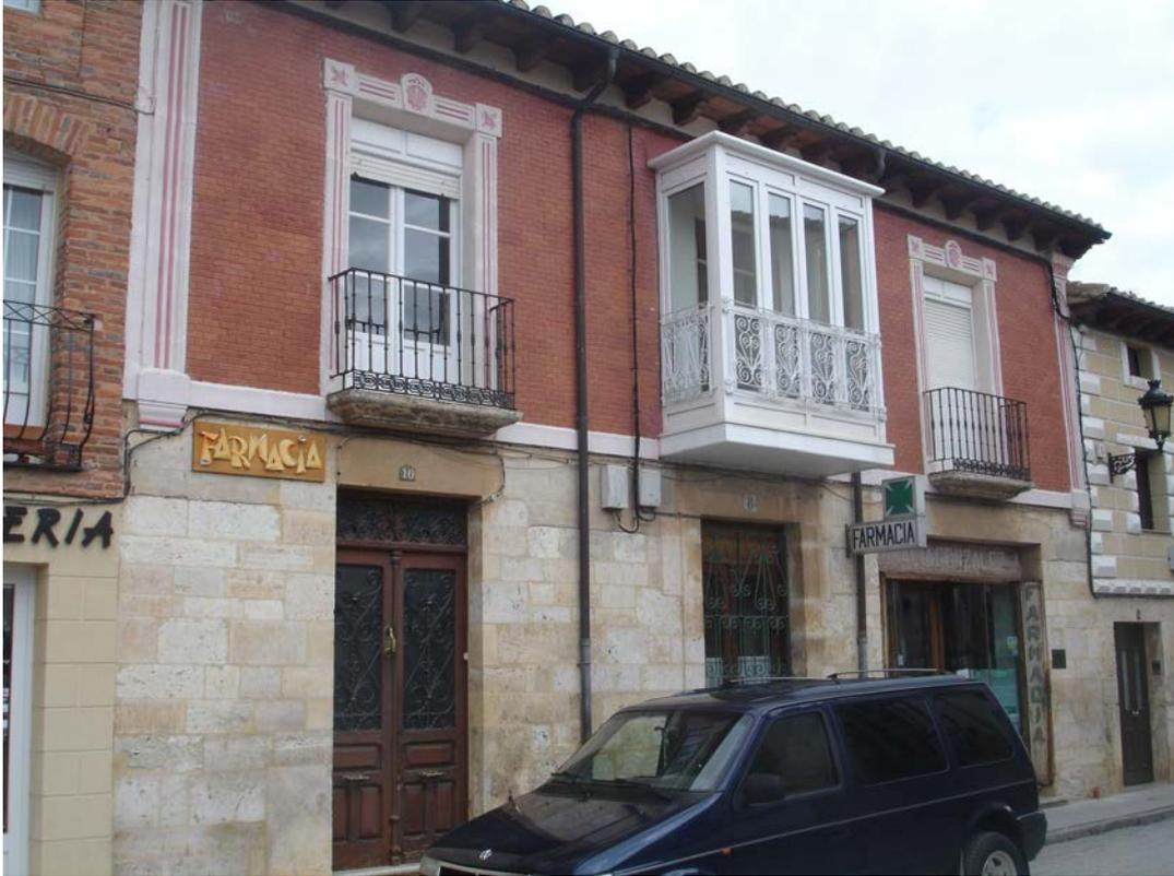
Edificio de vivienda. Dos plantas y tres ejes de vanos dispuestos de manera regular. Planta baja de sillería, imposta de piedra y cuerpo superior de ladrillo con enmarcado de huecos y apilastrado. Galería de madera en planta primera. Alero de canes de madera. Alteración de uno de los huecos en planta baja.
