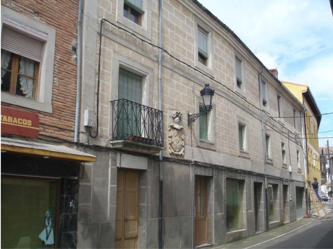
Edificio de vivienda. Tres plantas y seis ejes de vanos dispuestos regularmente. Fachada con revoco imitando sillería y enmarcado de huecos, con tratamiento diferenciado de planta baja.
