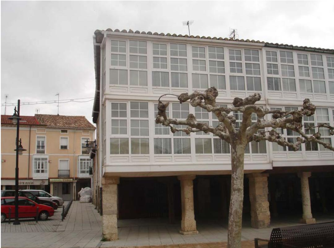
Edificio de viviendas levantado sobre el trazado de la antigua muralla. Destaca su soportal doble, que acredita su origen comercial y constituye el conjunto el conjunto más característico del núcleo. Tres alturas; planta baja sobre pilares de piedra de sección cuadrada y estructura de madera. Galerías de madera en las dos plantas superiores.
