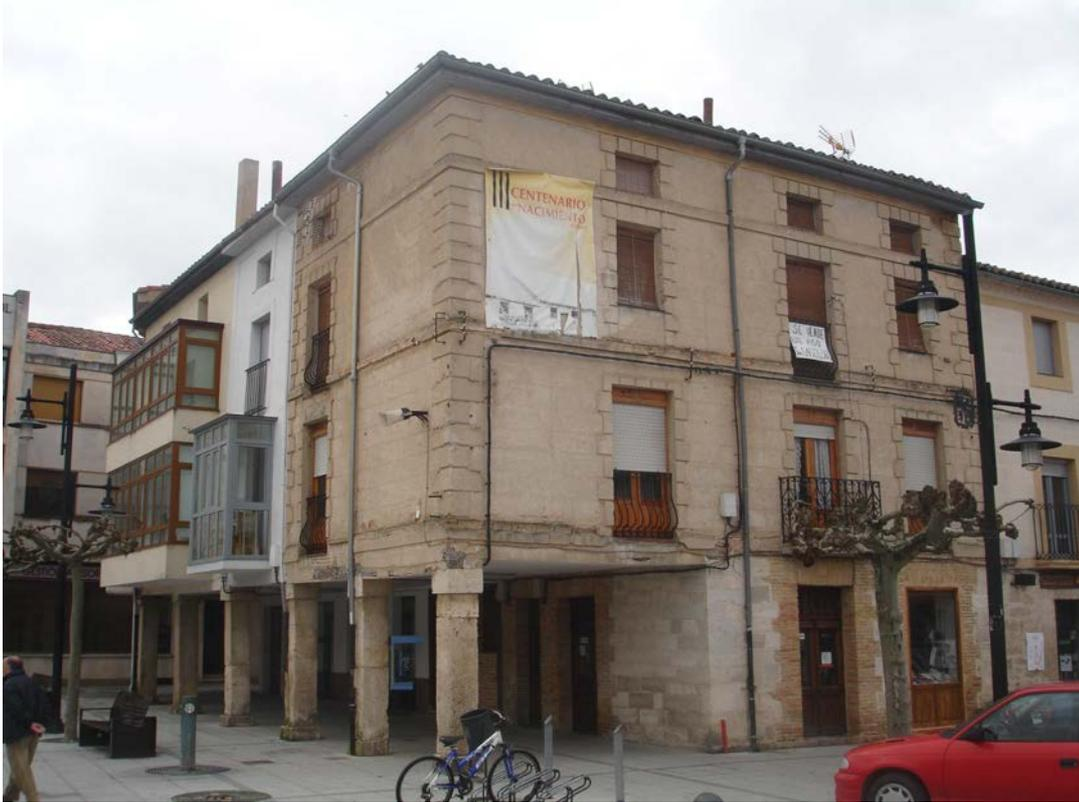
Edificio de viviendas. Cuatro plantas. Planta baja porticada característica del núcleo, con pies derechos de piedra de sección cuadrada. Revoco en plantas superiores, enmarcado de huecos en impostas. Altura decreciente de pisos.
