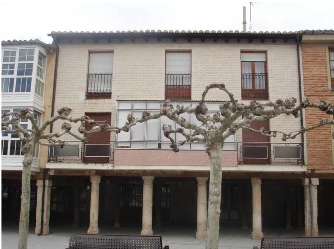
Edificio de viviendas levantado sobre el trazado de la antigua muralla. Destaca su soportal doble, que acredita su origen comercial y constituye el conjunto más característico del núcleo. Tres alturas; planta baja sobre pilares de piedra de sección circular, con cinco vanos. Tres ejes de vanos en plantas superiores. Fachada reformada con escaso acierto, en especial en el tratamiento de balcones y galería de planta primera.
