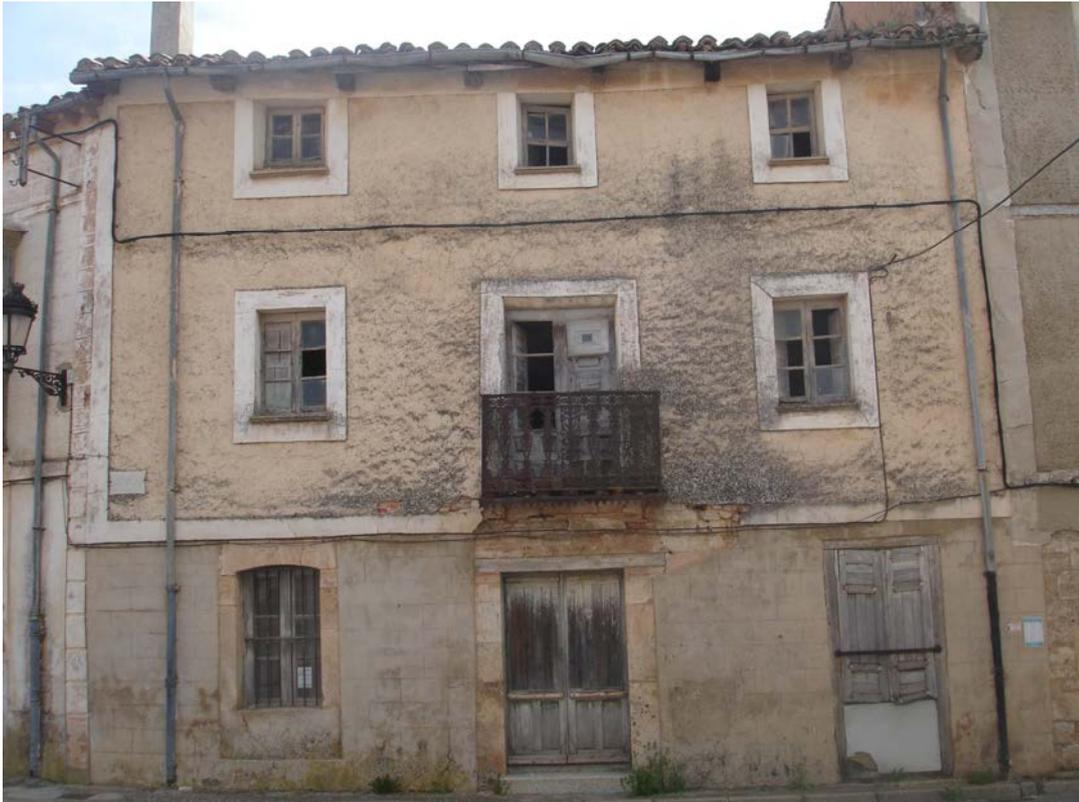
Edificio de vivienda. Tres alturas. Revoco en fachada con enmarcado de huecos e impostas. Balcón en planta primera. Alero de canes de madera.
