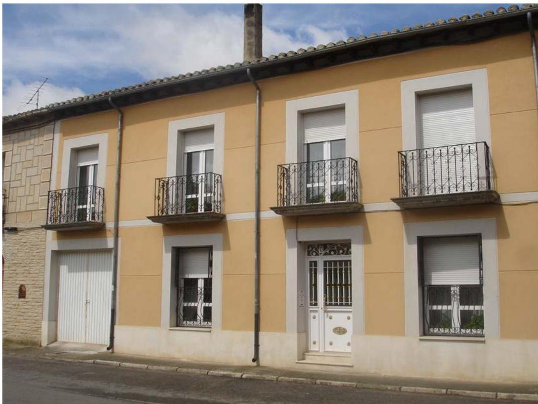
Edificio de vivienda entre medianeras que conforma un conjunto de cierta uniformidad dentro del núcleo. Dos plantas, cuatro ejes de vanos. Balcones en planta primera. Revoco a la tirolesa, enmarcado de huecos, zócalo e imposta. Alero de madera.
