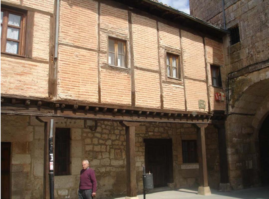
Construcción tradicional, perteneciente al conjunto más antiguo del núcleo. Dos plantas, construidas a base se entramado de madera, con res ejes de huecos. Planta baja porticada, pies derechos de madera sobre basas de piedra y fábrica de mampostería en interior del soportal. Cuerpo superior de ladrillo macizo de llaga ancha compactando entramado. Alero de canes de madera. Ha sido recientemente restaurado en su interior.
