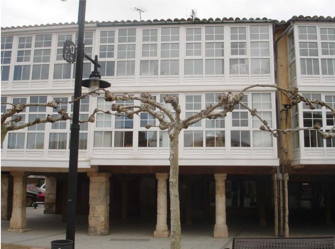
Edificio de viviendas levantado sobre el trazado de la antigua muralla. Destaca su soportal doble, que acredita su origen comercial y constituye el conjunto más característico del núcleo. Tres altura; planta baja sobre pilares de piedra de sección circular y estructura de madera. Galerías de acero en las dos plantas superiores.
