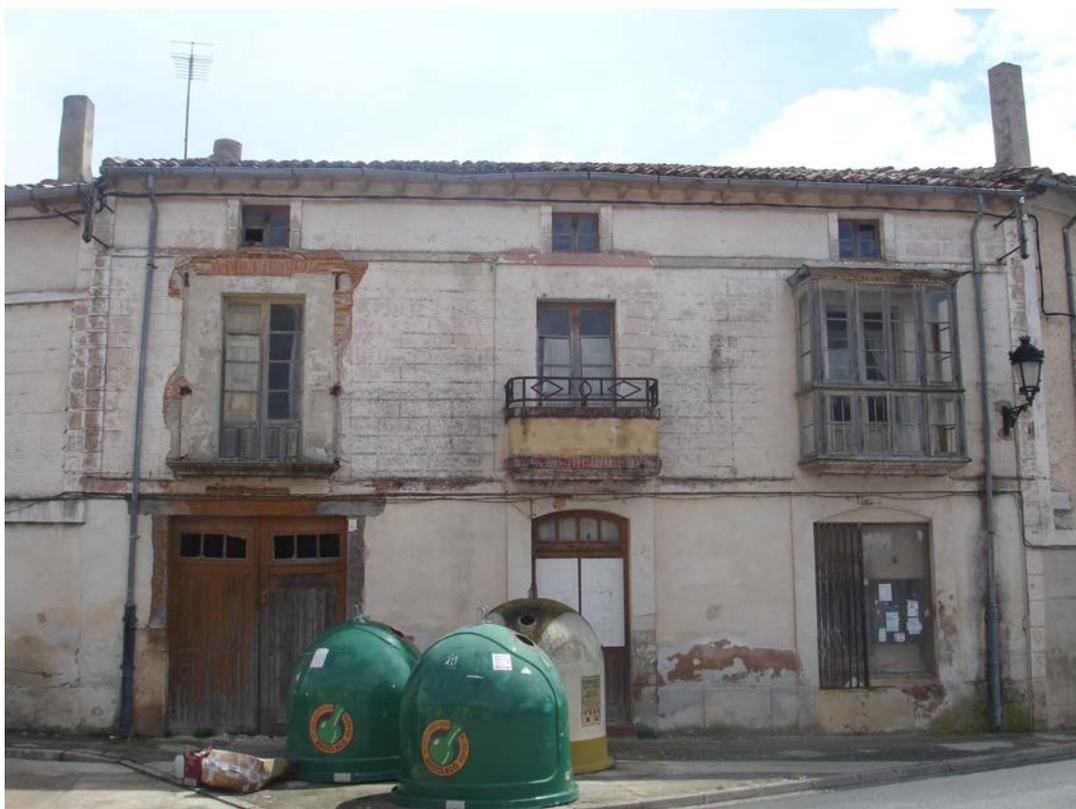
Edificio de vivienda. Tres alturas. Revoco en fachada con enmarcado de huecos e impostas. Galerías y balcón en planta primera. Alero con canes de madera.
