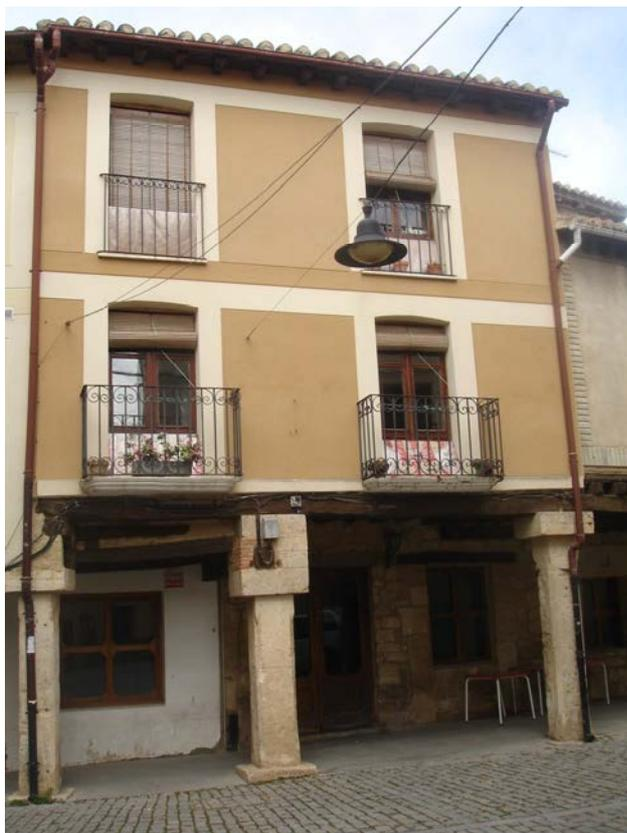
Construcción tradicional, situada en el eje más primitivo de la ciudad. Tres plantas y dos ejes de vanos. Planta baja porticada. Pies derechos de piedra de sección cuadrada y estructura de entramado de madera. Revoco en plantas superiores, con huecos enmarcados, dinteles de arco rebajado y balcones diferenciados por plantas. Alero de canes de madera.
