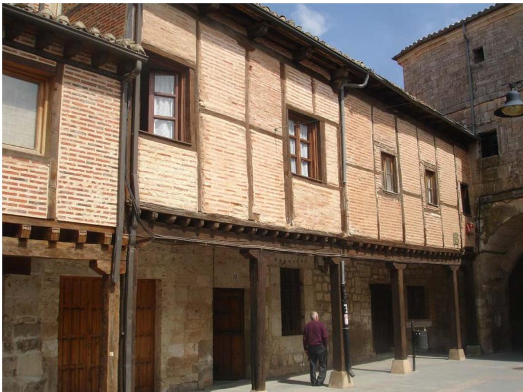
Construcción tradicional, perteneciente al conjunto más antiguo del núcleo. Dos plantas, construidas a base de entramado de madera, con res ejes de huecos. Planta baja porticada, pies derechos de madera sobre basas de piedra y fábrica de mampostería en interior del soportal. Cuerpo superior de ladrillo macizo de llaga ancha compactando entramado. Alero de canes de madera. Forma un único edificio con el contiguo.
