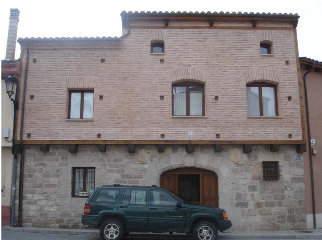
Cuerpo inferior de mampostería. Dos cuerpos superiores de ladrillo macizo sobre canes de madera, con arcos de descarga en huecos. Cornisa originalmente de hiladas de ladrillo, de la que se conserva sólo un tramo. Puerta de entrada con arco rebajado flanqueado por dos escudos nobiliarios, actualmente cegada.
