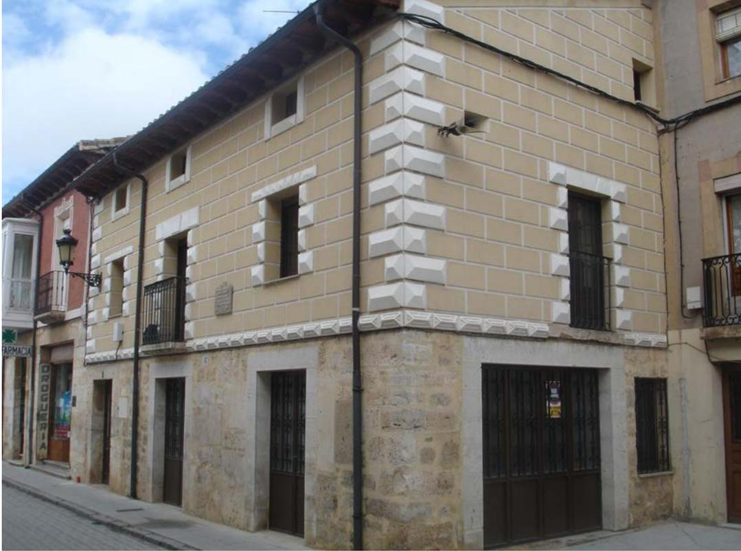
Edificio de vivienda. Dos plantas y desván, con tres ejes de vanos a fachada principal con separación uniforme. Planta baja de mampostería. Revoco en cuerpo superior, con almohadillado de sillares y enmarcado de huecos. Alero revestido
