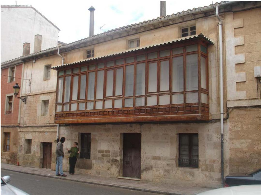
Edificio de vivienda. Dos plantas y desván, con tres ejes de vanos en fachada. Planta baja de mampostería y cuerpo superior con revoco y galería de madera en toda la longitud. Alero de canes de madera.
