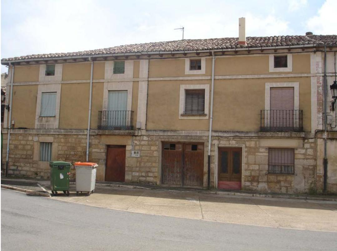
Edificio de vivienda. Tres plantas. Mampostería en planta baja. Revoco en plantas superiores, con enmarcado de huecos e impostas. Balcón en planta primera. Alero con canes de madera.
