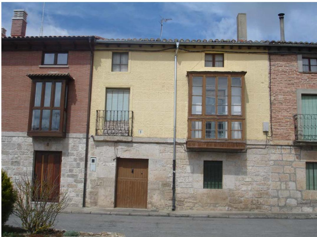
Edificio de vivienda entre medianeras que conforma parte de un conjunto de cierta uniformidad dentro del núcleo. Tres plantas, tres ejes de vanos , galería y balcón en planta primera. Mampostería en planta baja, imposta de piedra y fingido de sillares en plantas superiores.
