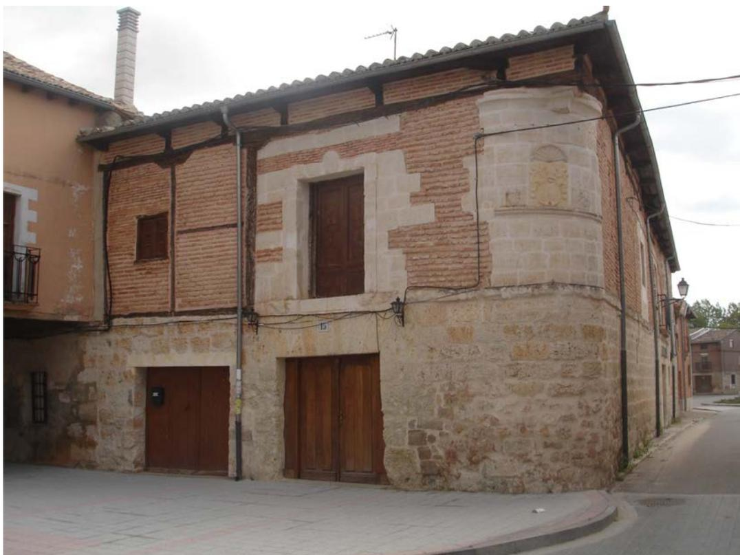
Edificio original del S. XVIII. Resulta de interés la esquina redondeada, donde se sitúa el escudo de armas. Dos plantas, construido en sillería con imposta en todo su perímetro y alero de madera. En épocas posteriores se ha revestido la piedra, e incluso se han sustituido algunas piezas.
