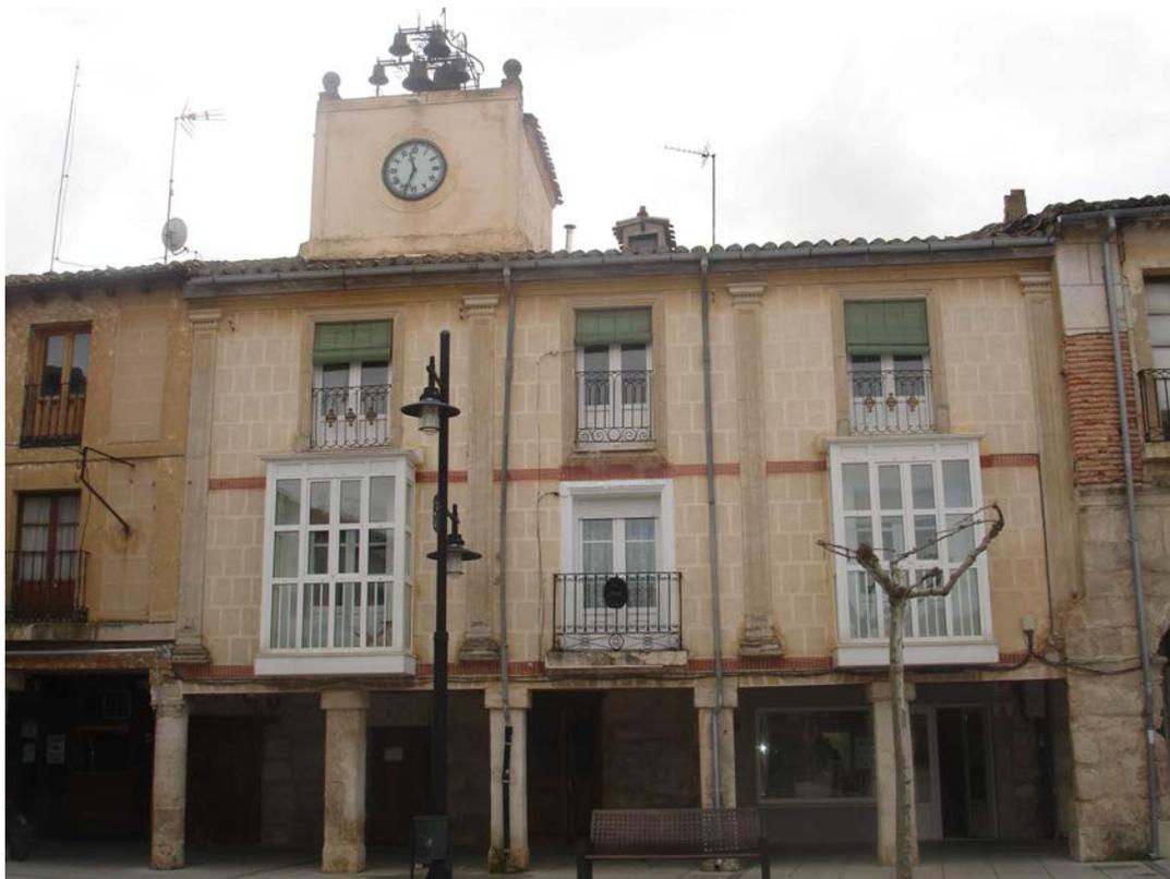
Edificación residencial. Tres plantas. Planta baja porticada, con pies derechos de piedra de sección cuadrada. Fingido de sillares en plantas superiores con enmarcado de huecos en impostas. Pilastras estriadas de doble altura. Galerías de madera en vanos extremos de planta primera. Torre con reloj y campanario. Alero con canes de madera.
