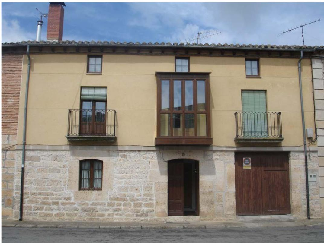
Edificio de vivienda entre medianeras que conforma parte de un conjunto de cierta uniformidad dentro del núcleo. Tres plantas, tres ejes de vanos . Galería central y balcones laterales en planta primera. Mampostería en planta baja., imposta de piedra y revoco en plantas superiores con enmarcado de huecos. Alero de canes de madera. Huevo de garaje abierto en planta baja.
