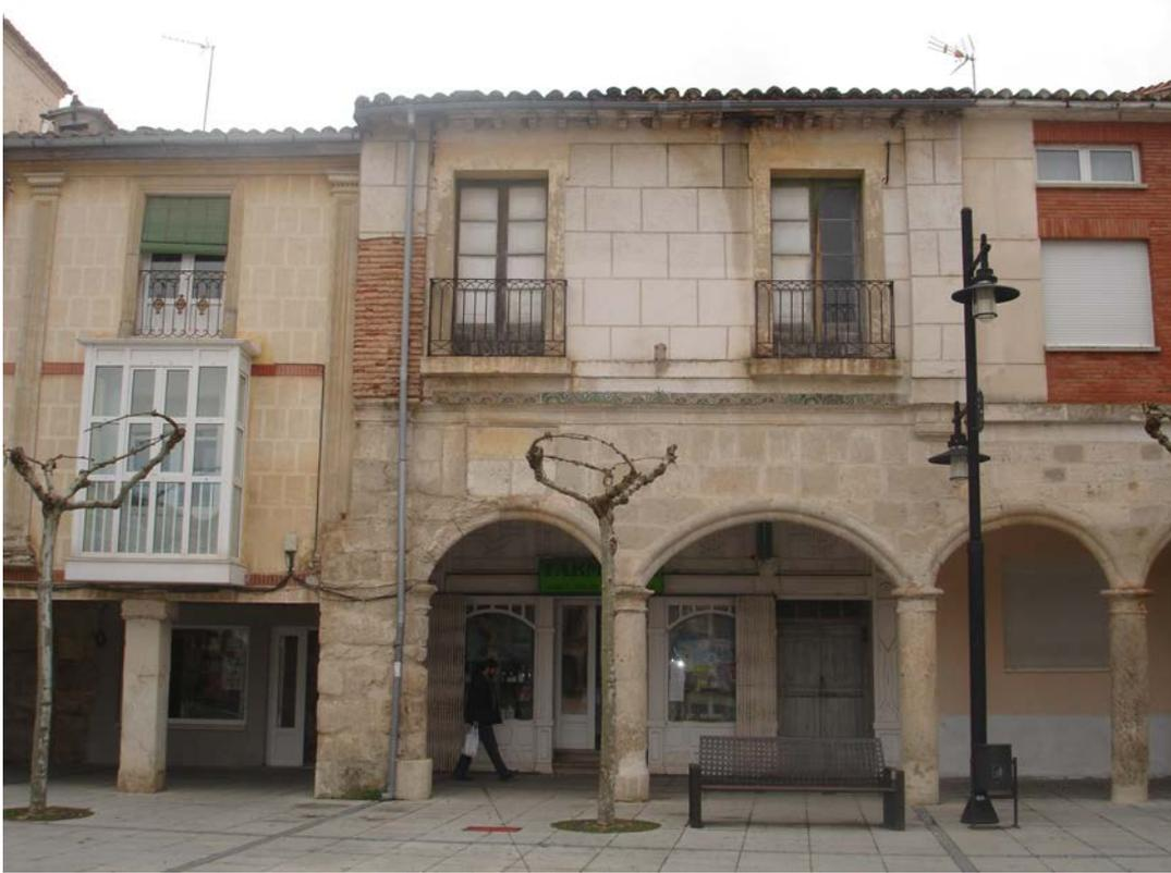
Edificación residencial. Dos plantas. Planta porticada, con pies derechos de piedra de sección circular y arcos rebajados. Fingido de sillares en planta superior con enmarcado de huecos. Alero con canes de madera.
