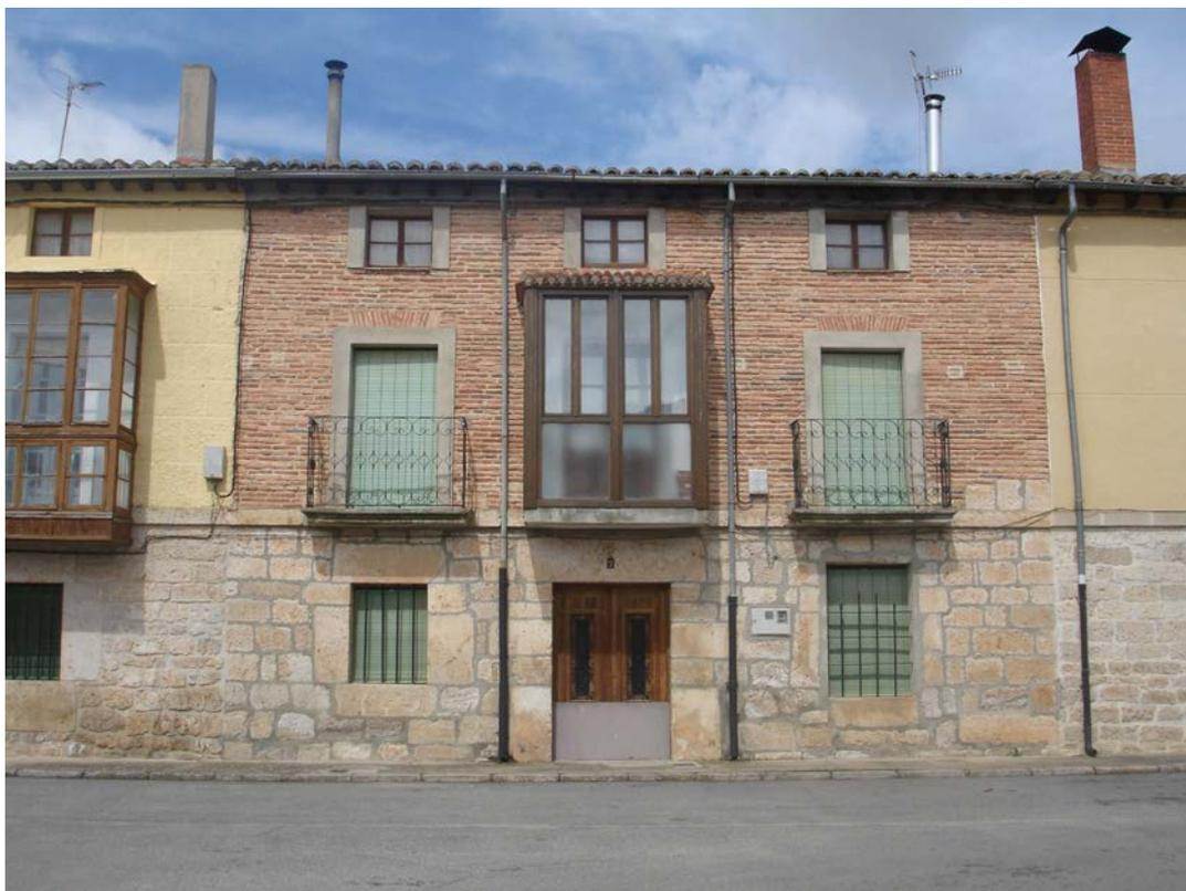
Edificio de vivienda entre medianeras que conforma parte de un conjunto de cierta uniformidad dentro del núcleo. Tres plantas, tres ejes de vanos . Galería central y balcones laterales en planta primera. Mampostería en planta baja., imposta de piedra y revoco en plantas superiores con enmarcado de huecos.
