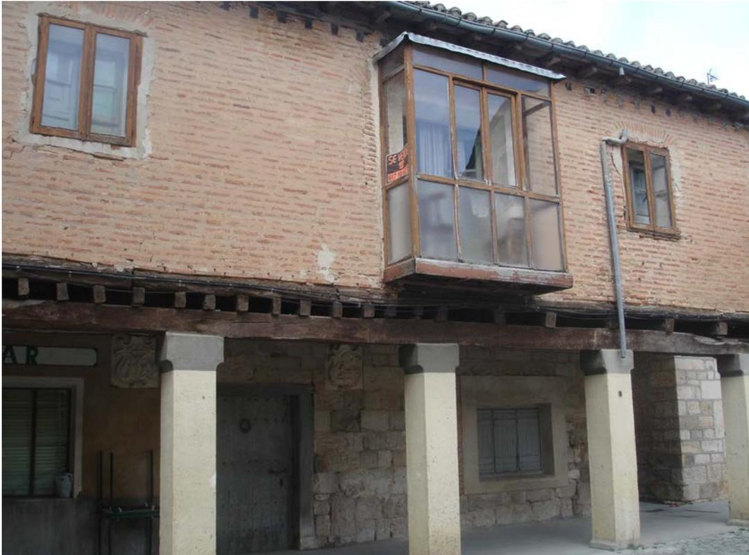
Construcción tradicional, situada en el eje más primitivo de la ciudad. Planta baja porticada. Se han sustituido los pies derechos por soportes de hormigón. Estructura de entramado de madera. Cuerpo superior de ladrillo macizo de llaga ancha compactando entramado. Alero de canes de madera.
