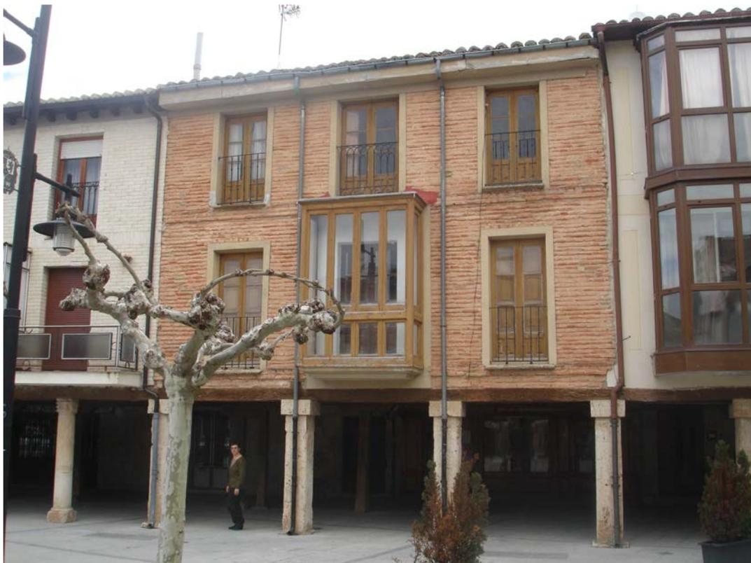
Edificio de viviendas levantado sobre el trazado de la antigua muralla. Destaca su soportal doble, que acredita su origen comercial y constituye el conjunto más característico del núcleo. Tres alturas y tres ejes de vanos. Planta baja sobre pilares de piedra de sección cuadrada. La fachada ha sido reformada. El valor del ladrillo queda un tanto desmerecido en el enmarcado y tratamiento general de los huecos. Galería de madera en hueco central de planta primera.
